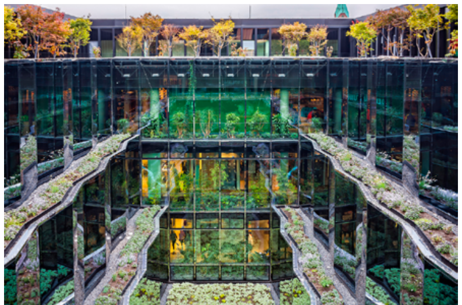
Joseph-Pschorr - Haus Munich (c) Bayerische Hausbau
