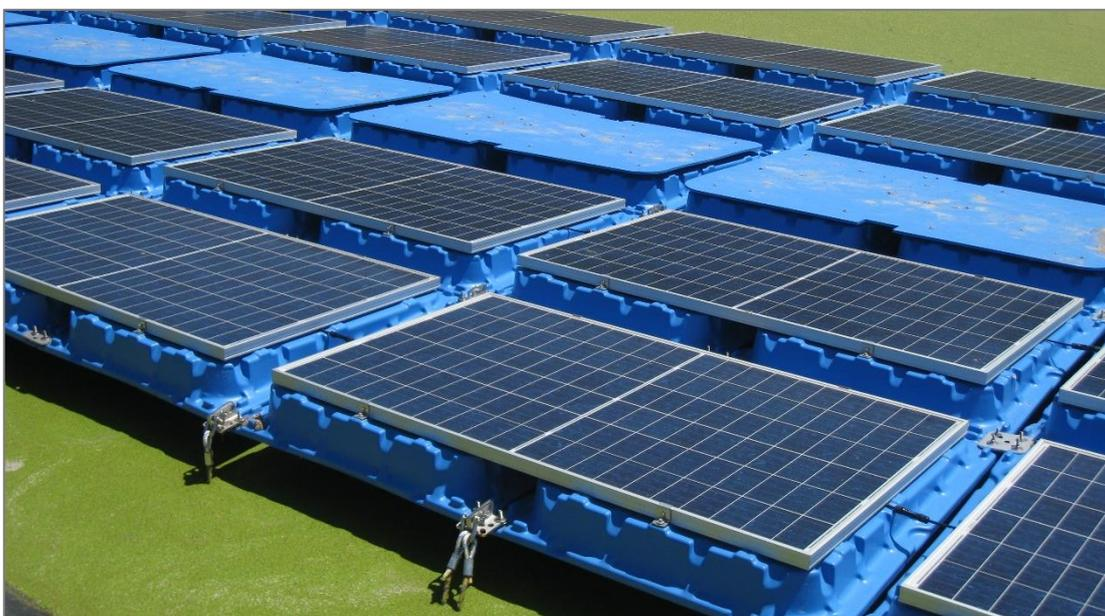
*Figura 8. Vista cercana del conjunto de paneles flotantes.*
