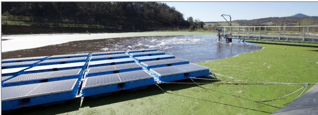
Figura 12. Balsa con paneles flotantes y aireador 2 en marcha.
