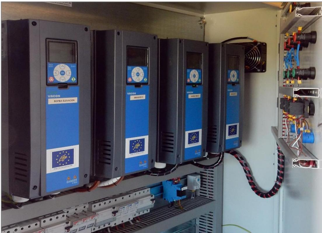
Figura 16. Armario con variadores de frecuencia para los aireadores y las bombas de elevación y riego.
