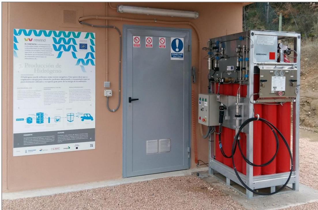
Figura 18. Zona de repostaje para el vehículo: Depósito de hidrógeno hasta 200 bar y sistema de repostaje.
