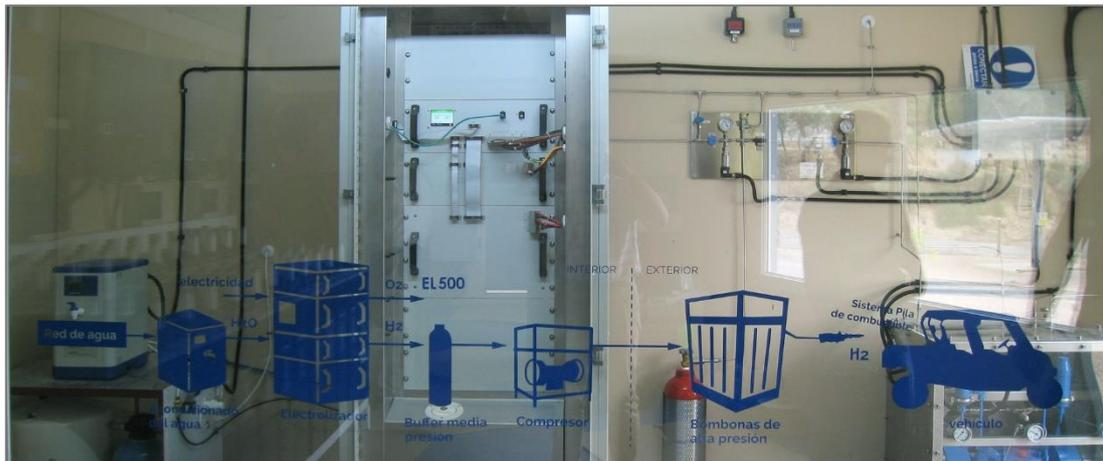
Figura 17. La zona de producción de hidrógeno. De izquierda a derecha: depurador de agua, electrolizador alcalino, depósito buffer a 20 bar, compresor hasta 200 bar.
