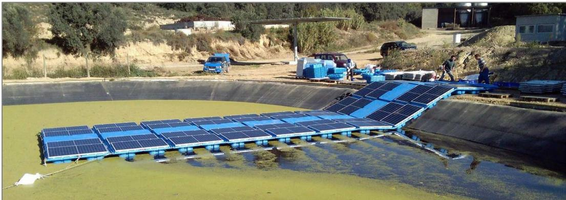
*Figura 7. Fase de montaje del conjunto flotante de paneles fotovoltaicos.*
