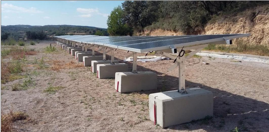
*Figura 9. Conjunto de paneles sobre suelo, antes de su conexión.*
