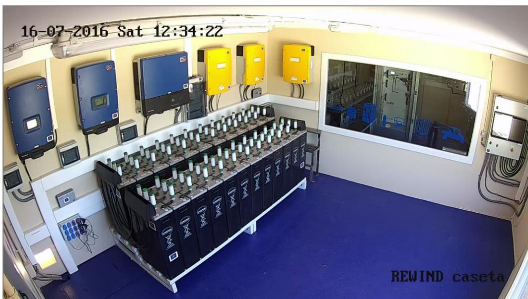
Figura 14. Cuarto técnico visto desde la cámara de vigilancia. Se aprecian los tres inversores solares (azules), los tres inversores de batería (amarillos), la batería, la ventana a la zona de producción de hidrógeno y el armario de control con pantalla táctil.
