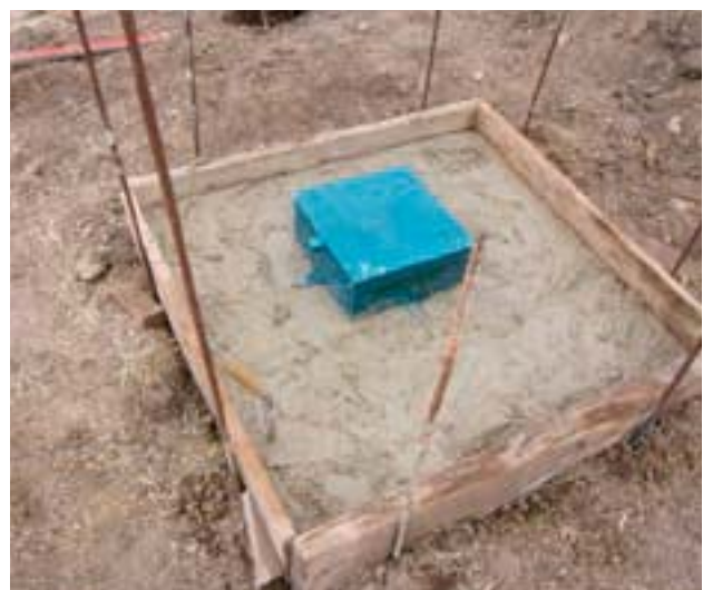
Detalle de la adecuación de protección realizada.
