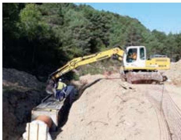
Obras para la construcción del bypass en el Barranco de Bailín.
