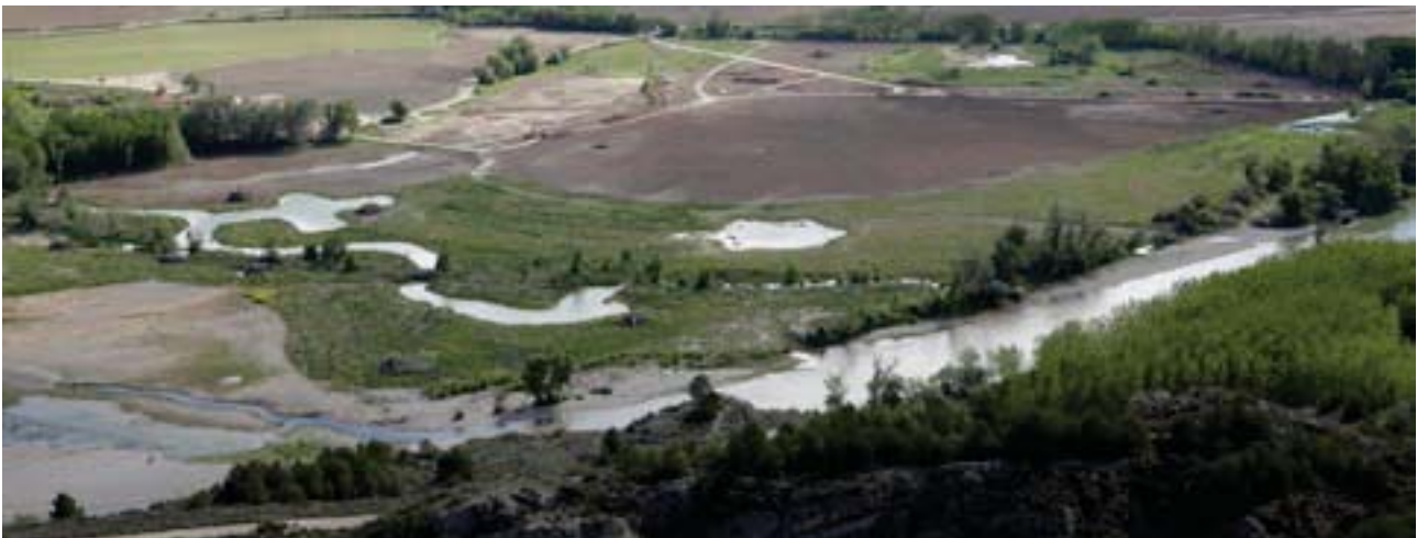
Nuevos humedales. Restauración fluvial río Arga en Funes.
