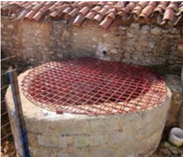
Vista general de la adecuación de protección realizada.
