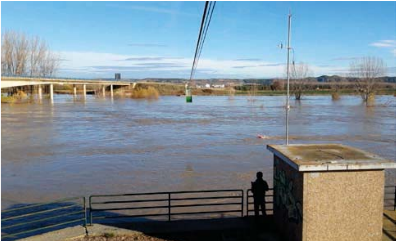
Medición de caudal.
