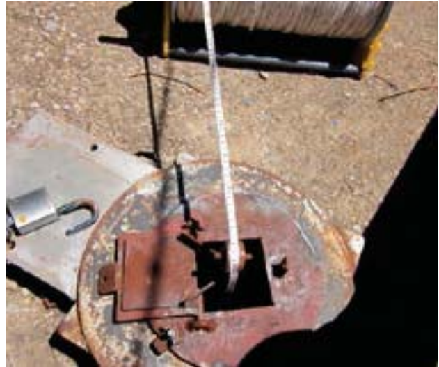
Polea para facilitar medición.
