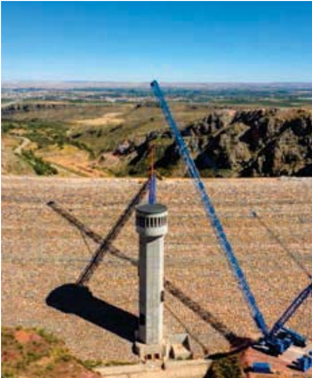
Presa de Mularroya vista general.
