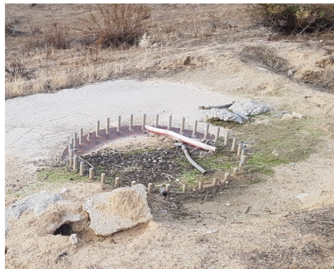
Cimentaciones de antiguos postes de publicidad ○
