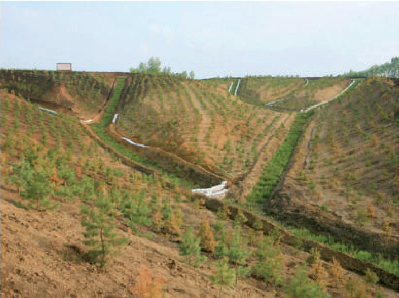
Figura 3.2.8.8. Medidas combinadas de conservación del suelo para el control de la erosión por cárcavas en una cuenca de las regiones montañosas del noreste de China (Foto L.Meng).
