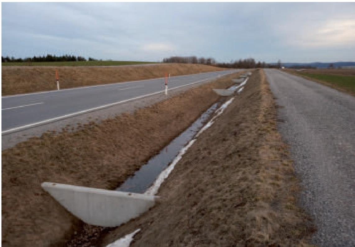
Figure 3.2.12.9. Recogida de agua en una zanja de la carretera (Foto T. Dostal).
