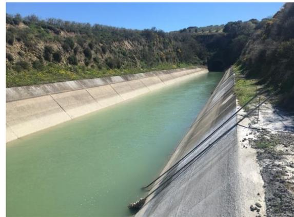
*En estas imágenes se observa el proceso de reparación y las varillas de inyección preparadas en los taladros ejecutados para la posterior inyección de lechada para relleno del hueco.*
