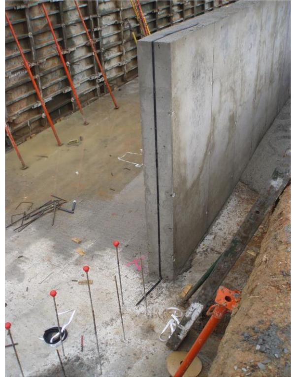
➤ **SELLADO DE JUNTA CON LÁMINA DE PVC O EPDM**
