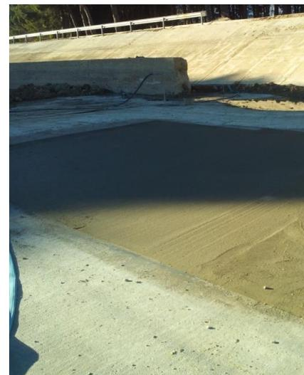
*En estas imágenes se observa el proceso de inyección del hueco aparecido en solera de canal.*
