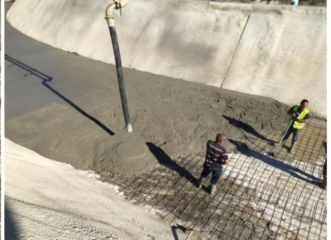
*Mallazo colocado en solera y hormigonado con bomba.*
