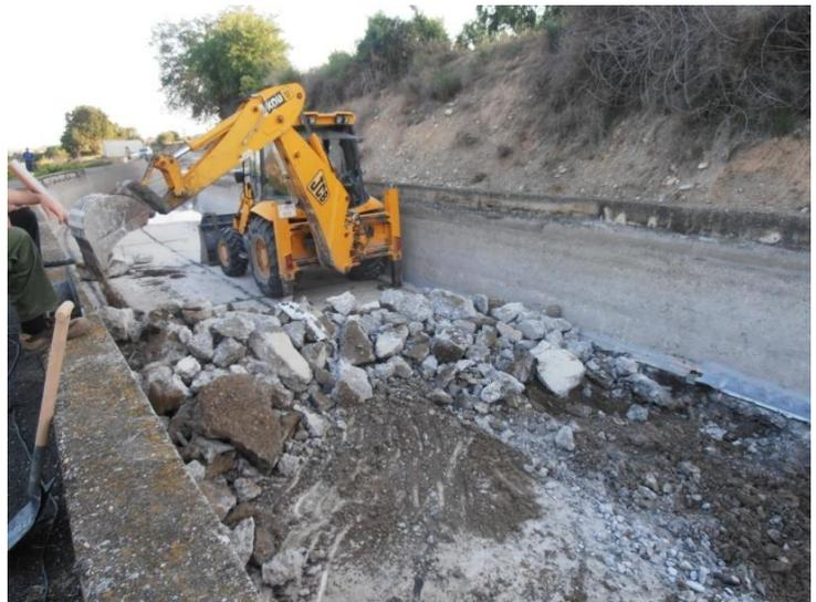
*Demolición de soleras en mal estado en el Canal de Piñana.*
