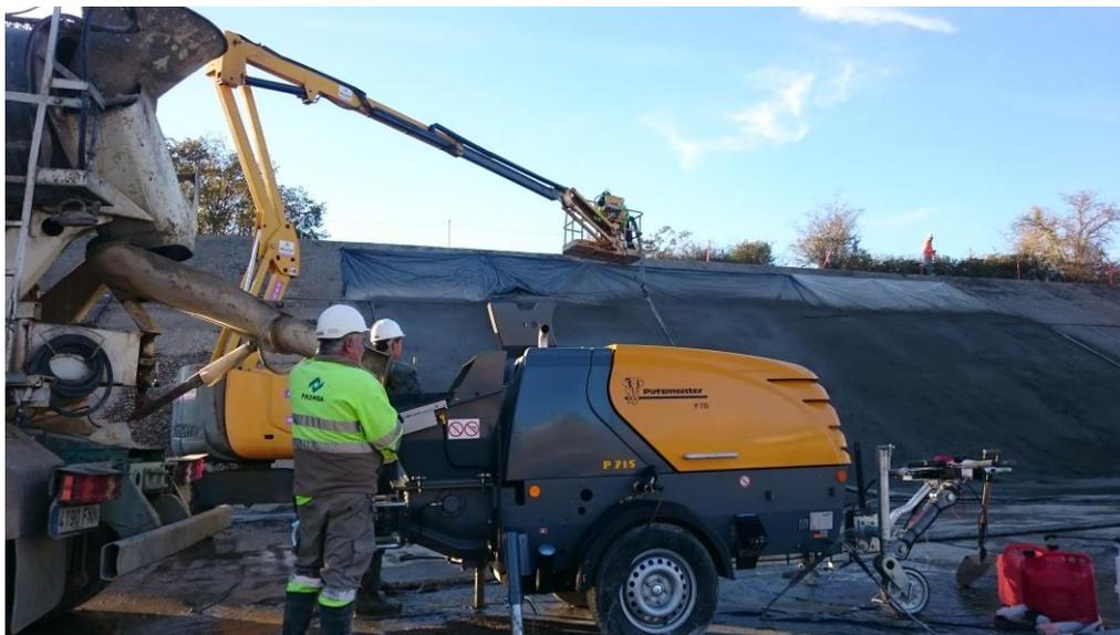
*Gunitadora Putzmeister P-715D en el canal de Gavet*
