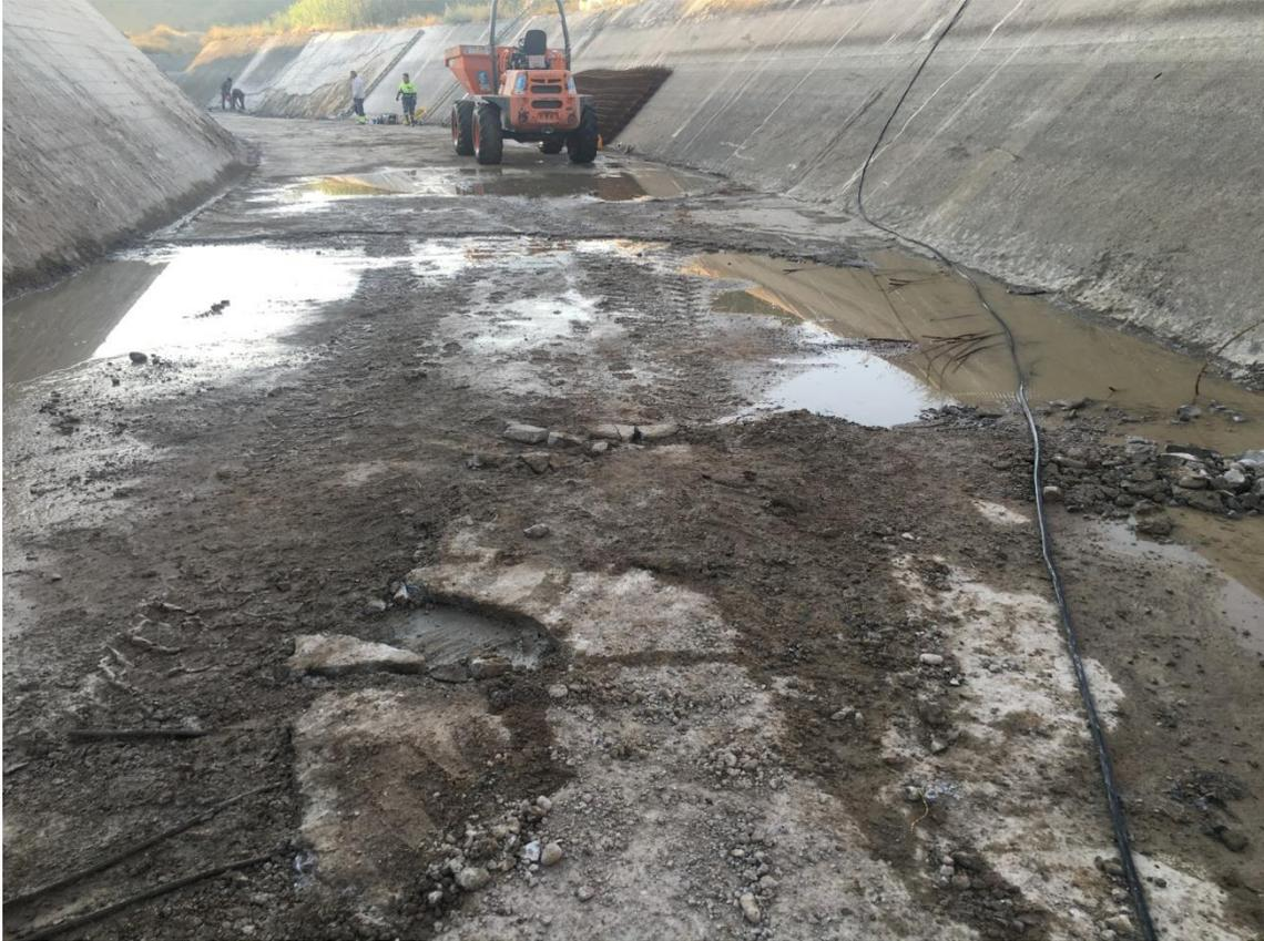
*Ejemplo de solera en pésimo estado (hundimientos, oquedades, etc.), pero hastiales solo con necesidades revestimiento de gunita*
