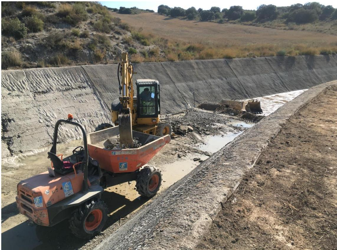
*Arranque de gunita deteriorada en el Canal de Aragón y Cataluña*
