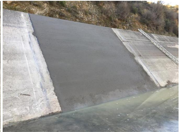
*Reperfilado del terreno y hormigonado y fratasado con rodillo.*
