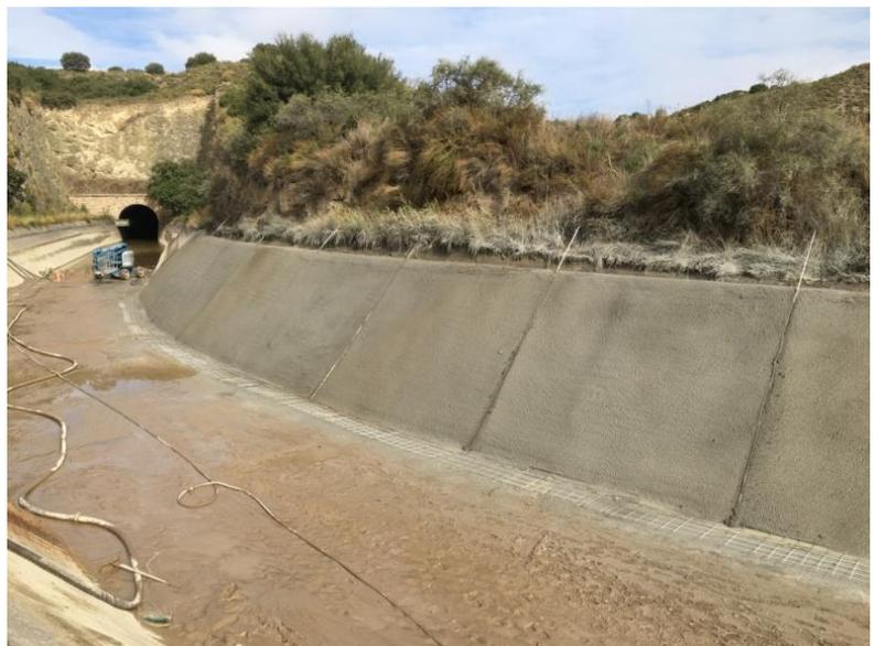
Gunitado el hastial, y previa re-limpieza de la solera se procede a colocar el mallazo de solera. y continuar el proceso según se desarrolla en la 2º Solución: Soleras continuas.
