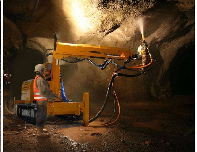
*Gunitado con minirobot en el interior de túnel.*
