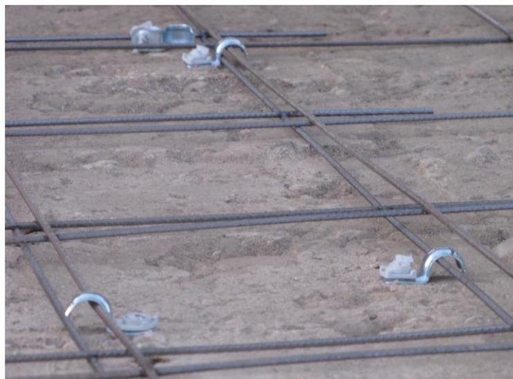
*Detalle de sujeción del mallazo a la superficie de hormigón existente, sobre la que se ha de gunitar.*
