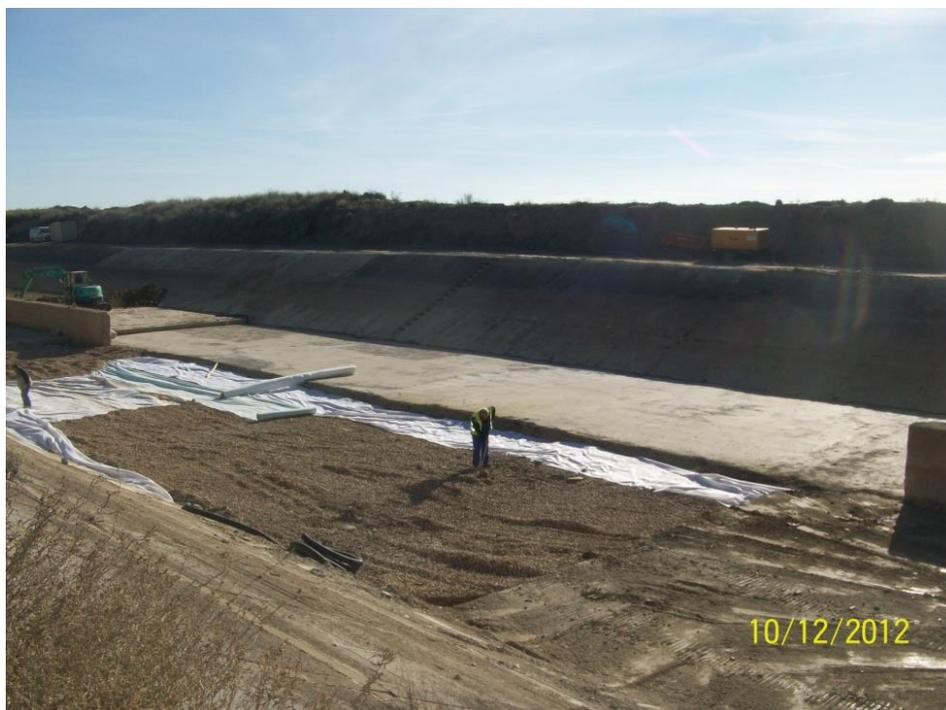
*Relleno con zahorras y lamina geotextil en el Canal de Monegros.*
