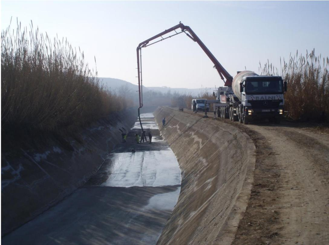
Se ejecutan habitualmente de manera denominada "solera corrida". Consiste en el hormigonado mediante bomba de toda la longitud de solera a ejecutar y posteriormente cuando el hormigón ha adquirido cierta consistencia proceder al corte de las juntas.
