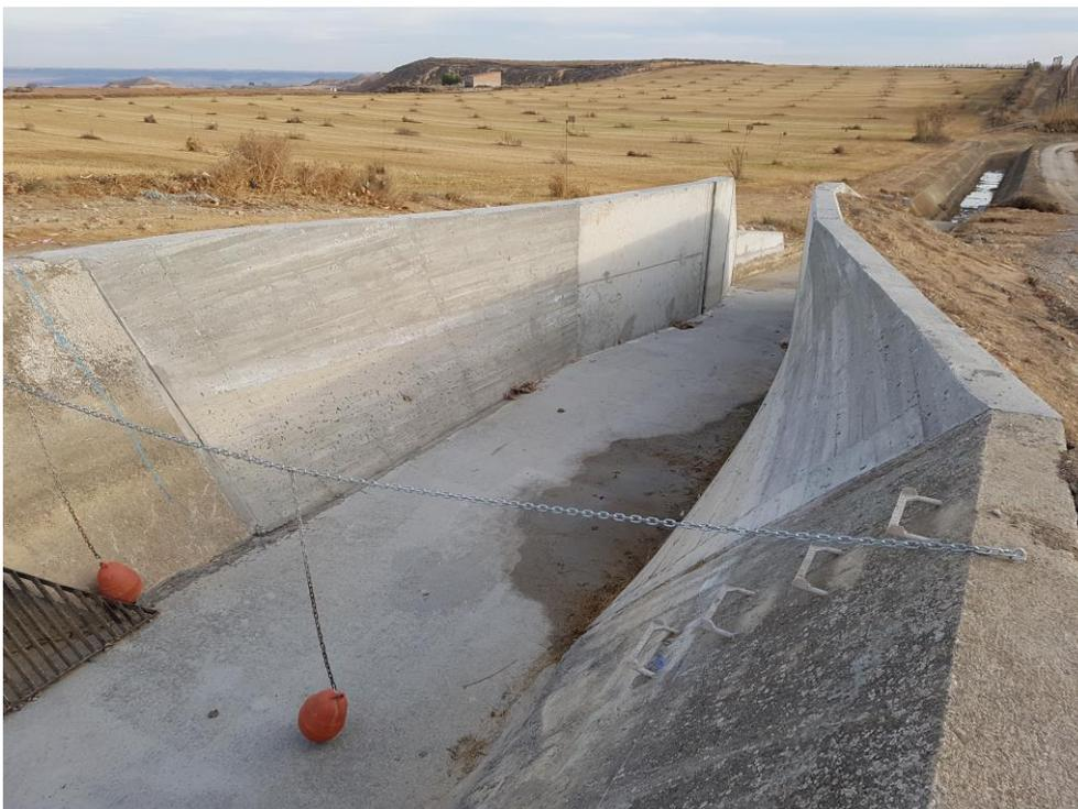
*Reconstrucción de la transición tipo paraboloides en el PK 38+800 del canal de Zaidin.*
