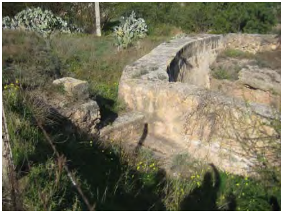
Figura 8. Azud de derivación de aguas turbias (de avenidas), en la Rambla del Zoco - Guadalupe (Costera Norte de Murcia). (Foto: E. Gil y J.M. Gómez, 13/01/2008).
