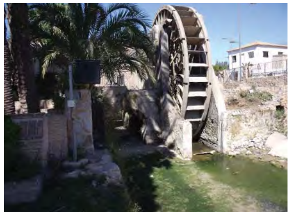
Figura 10 (abajo). Rueda de corriente baja elevadora de agua de Alcantarilla, en la Acequia de Barreras. Heredamiento del Mediodía. (Término de Alcantarilla). (Foto E. Gil y J.M. Gómez, 30/03/2013).
