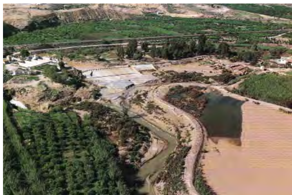
Figura 7. Azud de la Contraparada, cabeza del sistema de riego de la Huerta de Murcia. (Foto E. Gil y J. M. Gómez, 03/12/2003).
