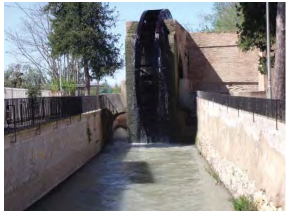
Figura 9 (arriba). Rueda de corriente baja elevadora de agua de La Nora, en la Acequia de la Aljufía. Heredamiento del Norte (Pedanía de La Nora-Murcia). (Foto E. Gil y J.M. Gómez, 30/03/2013).
