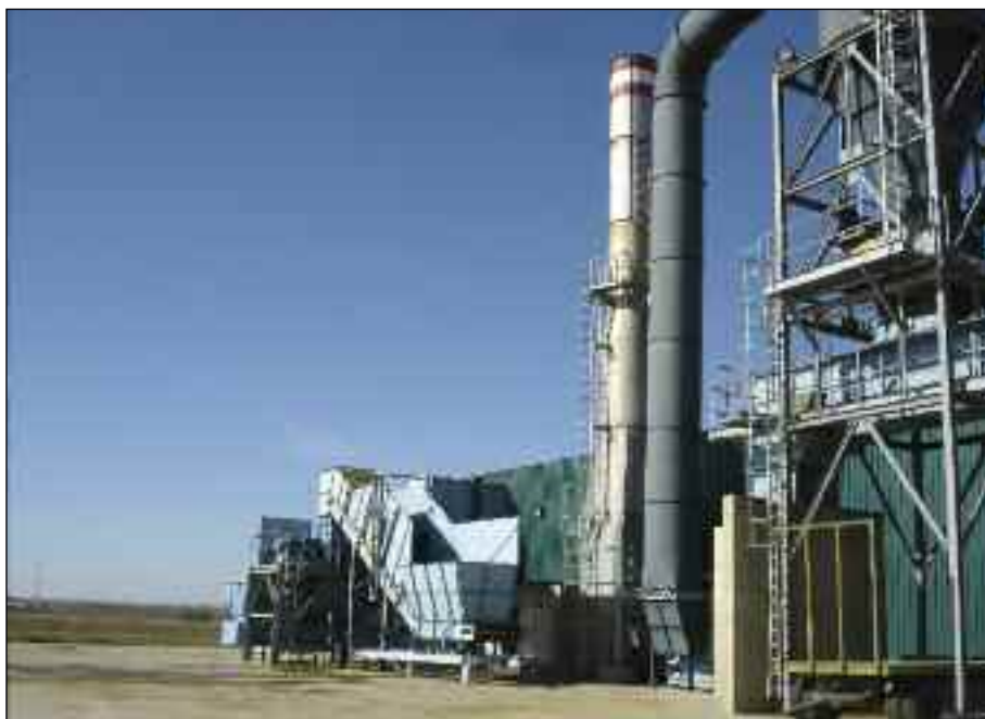
La eficiencia energética en sistemas de aire comprimido se puede mejorar optimizando su diseño.
