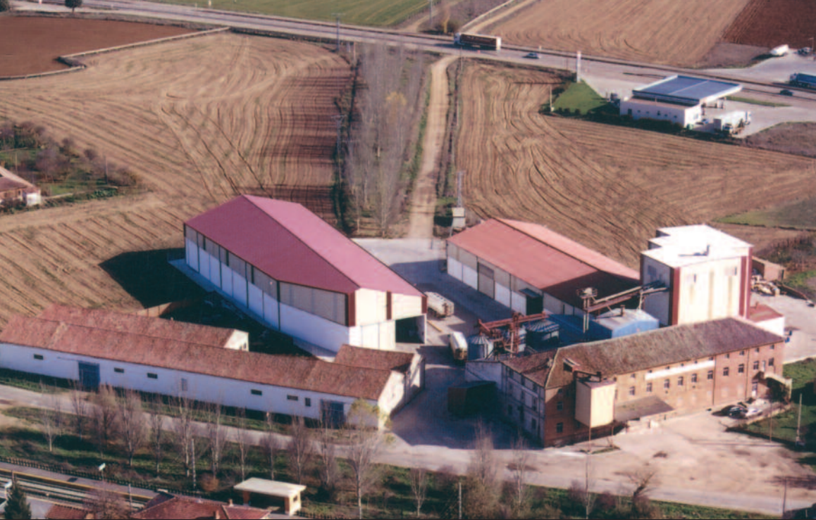
Instalaciones de Tierra de Campos en Osorno (Palencia).
