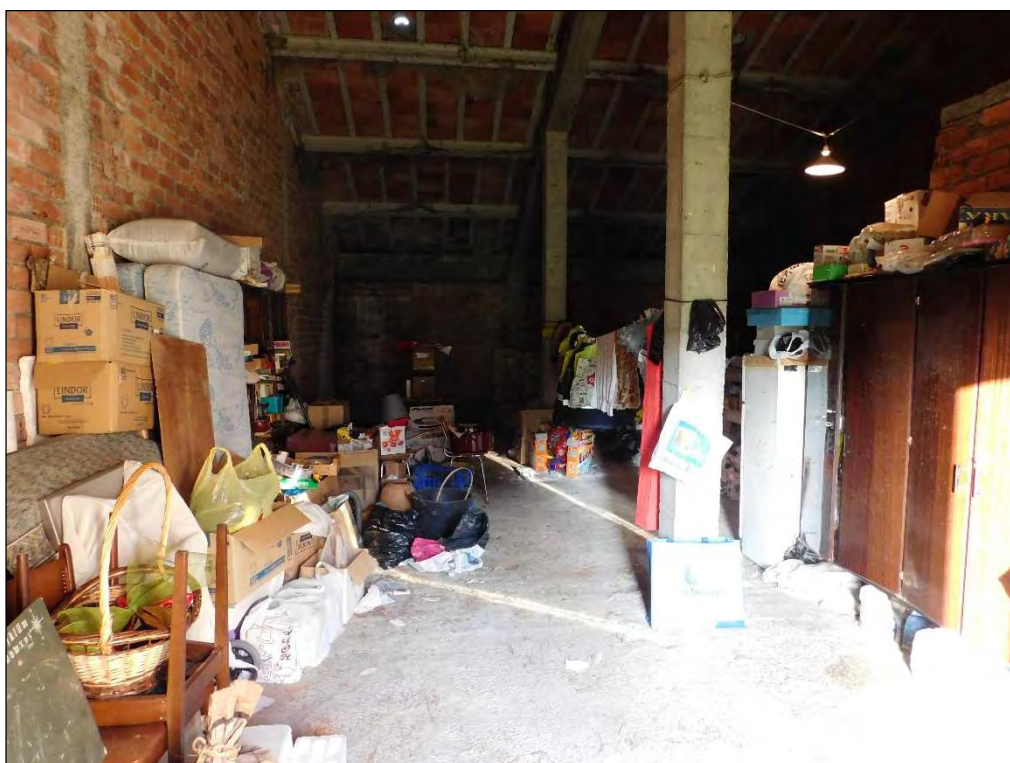
Ilustración 26. Interior del desván.
