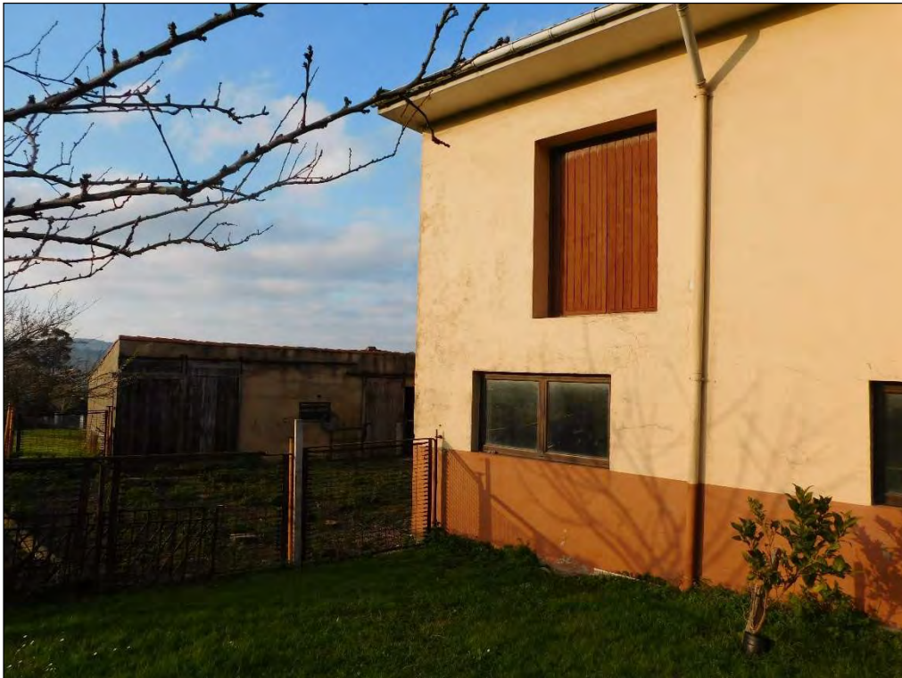
Ilustración 27. Cara Sur del edificio donde se aprecia el acceso al desván y los barracones traseros.
