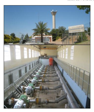
Desde esta estación de elevación se puede telecomandar el resto de estaciones del canal. Esto es posible gracias a la comunicación por fibra óptica dispuesta entre todas ellas. Han aprovechado el borde del canal para tender la línea de fibra.
