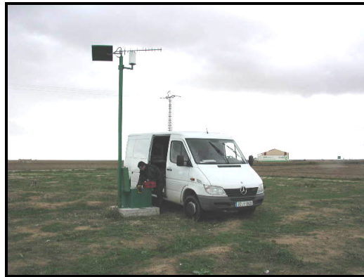
Figura 1.- Mantenimiento de equipos de la red de piezometría y calidad de aguas subterráneas.
